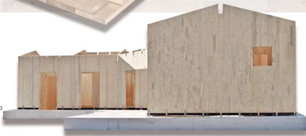
Esempio di costruzione al grezzo con pareti portanti MaxLam
