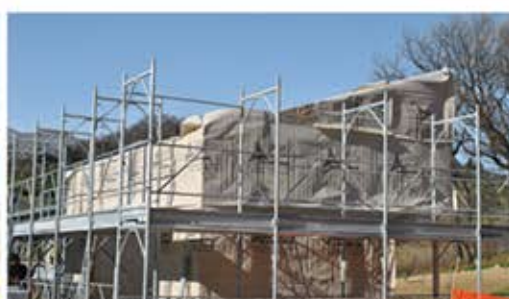
Rivestimento membrane e isolanti
