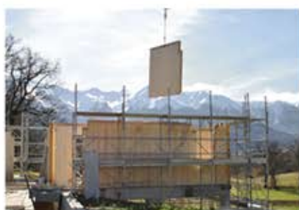
Esempio posizionamento pareti
